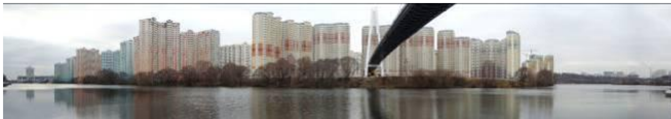
Рисунок 2.1. Вид на участок строительства с Москвы-реки.
