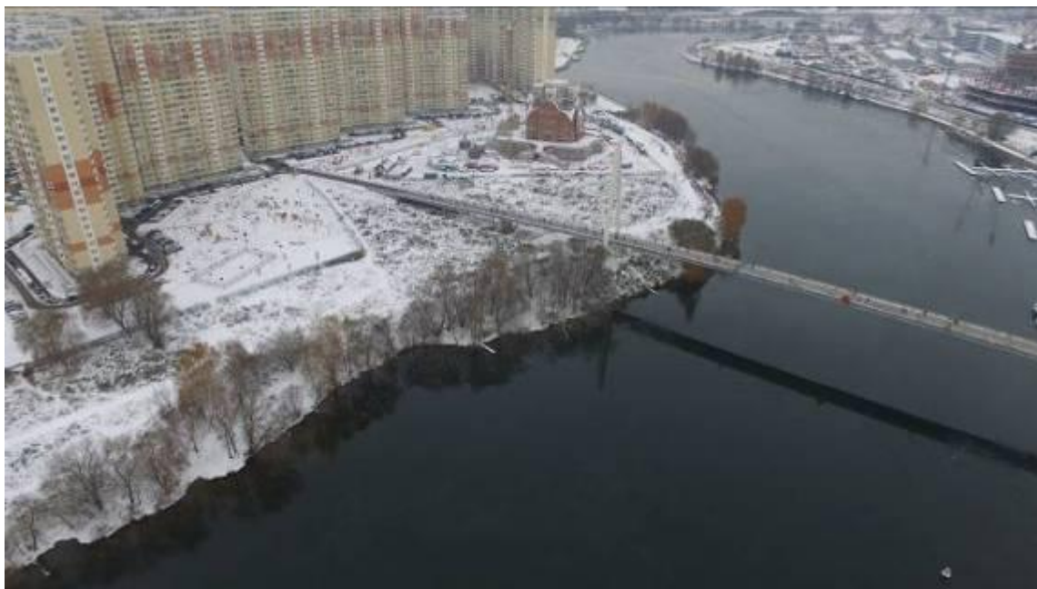
Рисунок 2.3. Вид территории строительства
