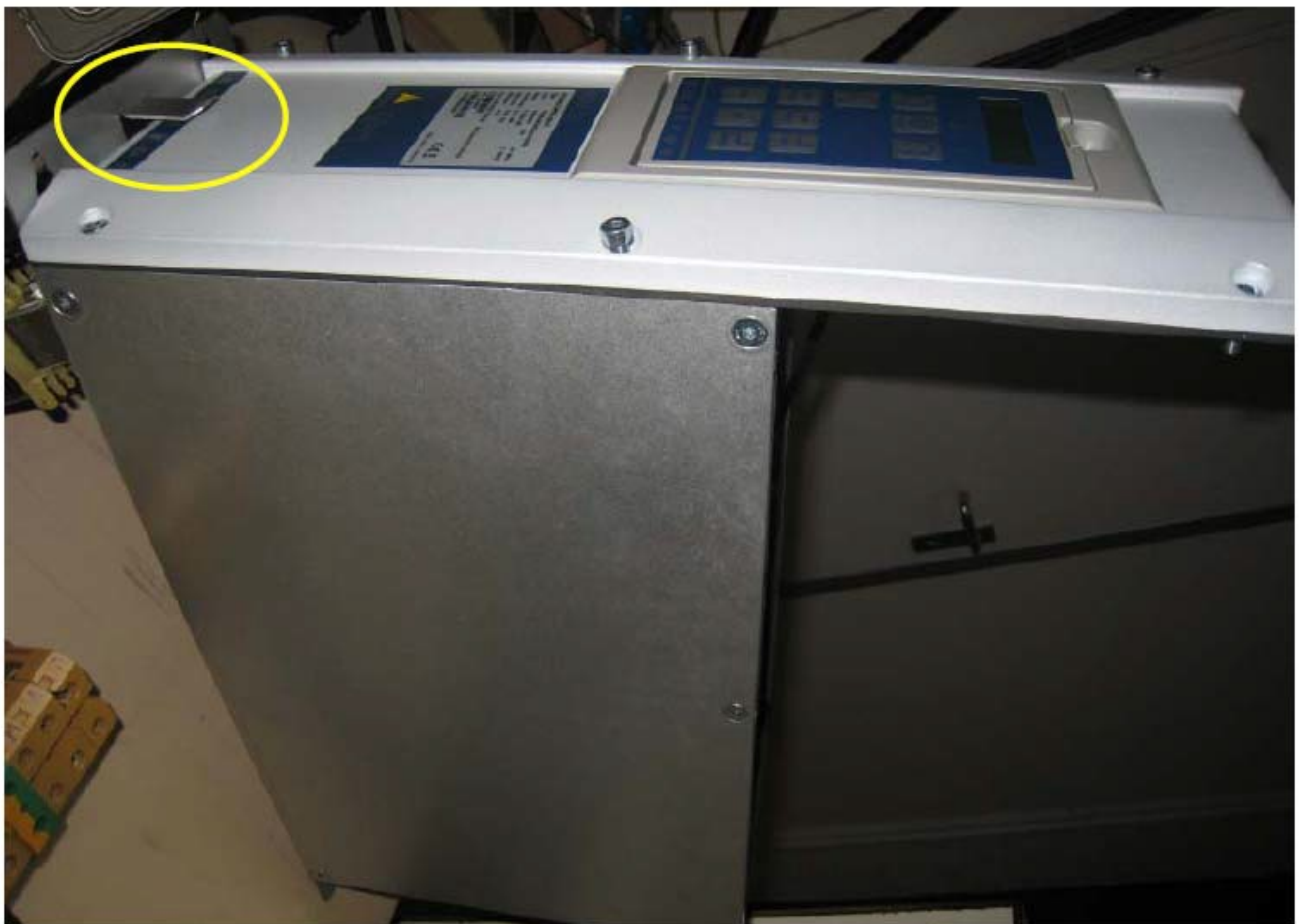
Рис.3 Размещение передней крышки преобразователей частоты серии VFX48-... при выполнении электромонтажных работ.
